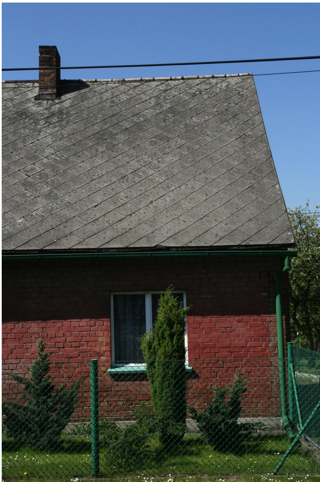
Rysunek 8 Dach budynku mieszkalnego pokryty płytami azbestowymi płaskimi Fotografia Agnieszka Chylak
