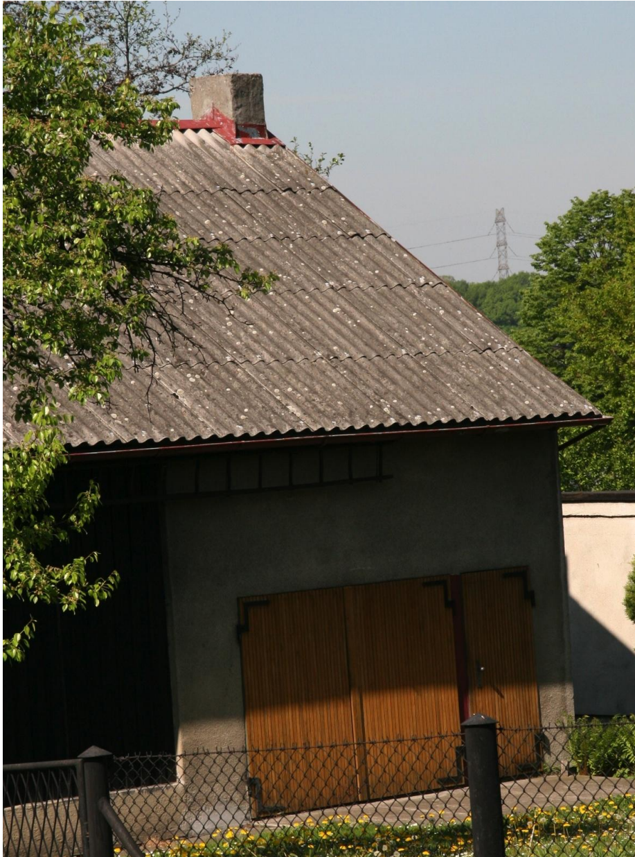
Rysunek 3 Dach pokryty płytami azbestowymi falistymi
